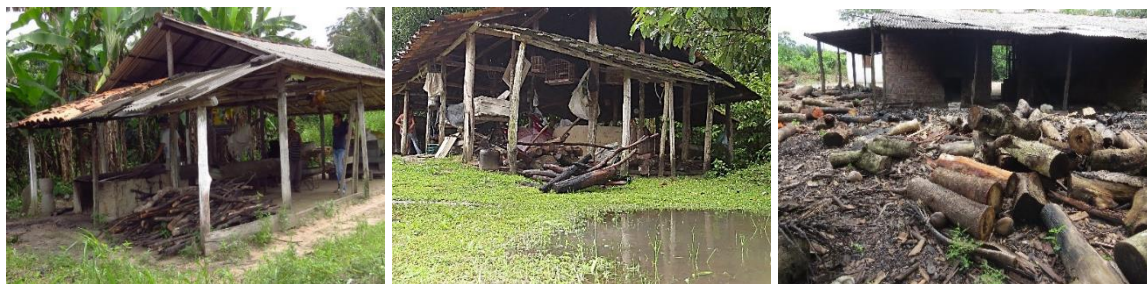
Figura 19: Armazenamento de lenha nas casas de farinha dos agricultores familiares no município Igarapé-Açu, nordeste do Pará.
