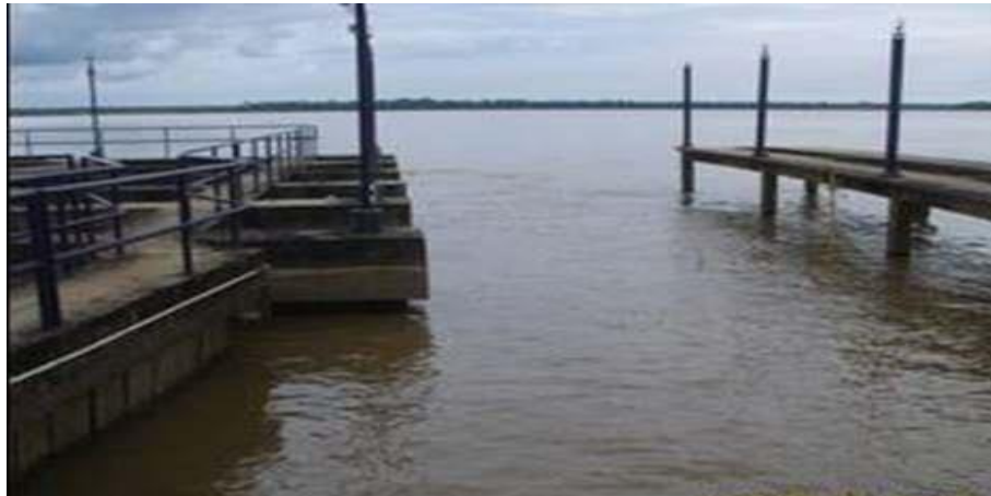
Figura 2. Captação de água superficial – Rio Guamá.
