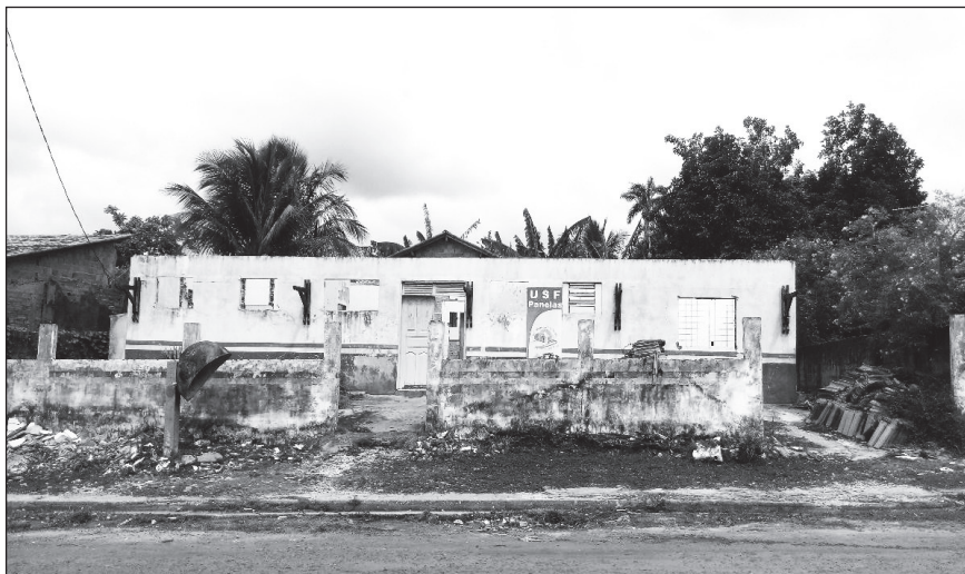
Figura 1 – Posto de saúde em São João de Pannels, Bonito-PA
