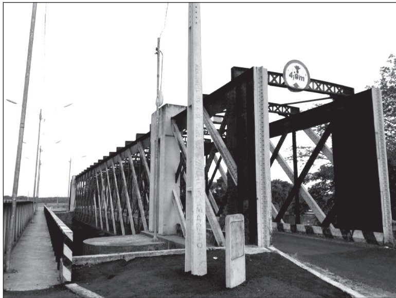
Figura 11 – Ponte sobre o Rio Livramento, por onde passava a ferrovia Belém-Bragança
