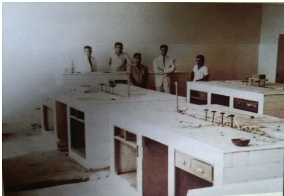
Fotografia 19 - Construção do Laboratório de Química da EAA, 1963
