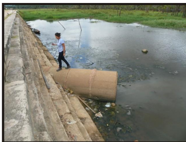
Fotografia 9 - Diques de contenção do bairro Caranazal.
