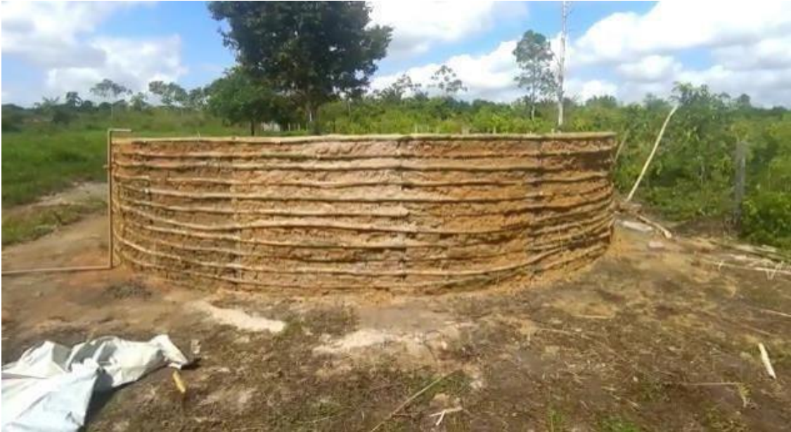
Figura 05 - Tanque suspenso com as paredes já preenchidas de argila.
