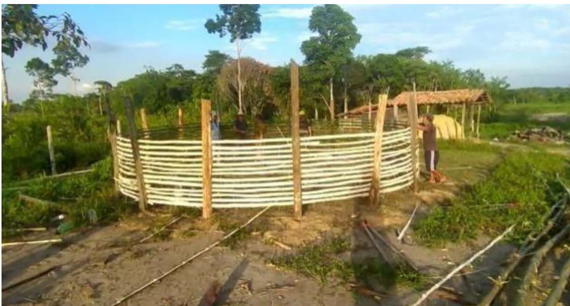
Figura 03 - Formação das paredes do tanque suspenso, sendo pregadas as varetas de bambu nas estacas.
