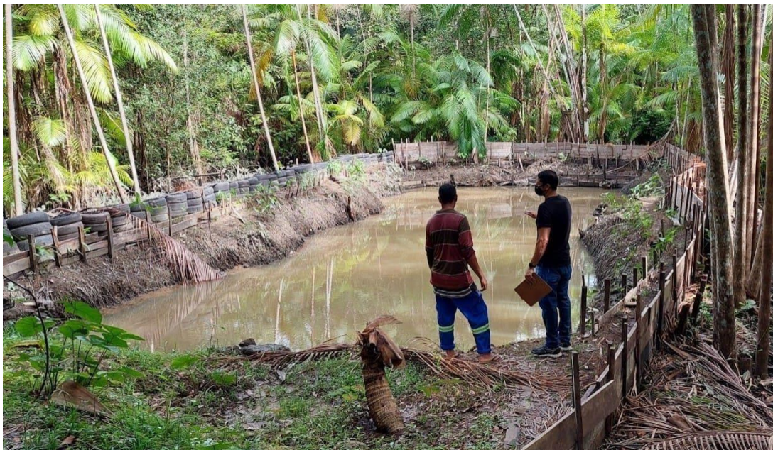
Figura 05 - Mostra as contenções prontas tanto com telas e pneus.
