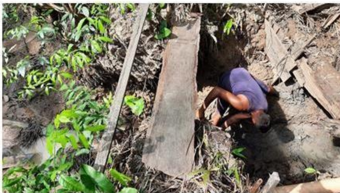
Figura 03 - Construção do viveiro.
