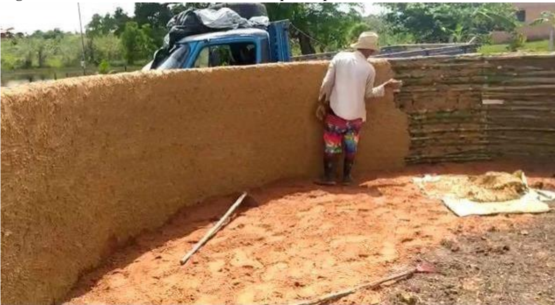
Figura 06 - Processo de acabamento do tanque suspenso.
