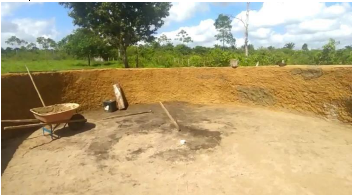
Figura 07 - Nivelamento do fundo do tanque suspenso com leve declividade ao centro do tanque.
