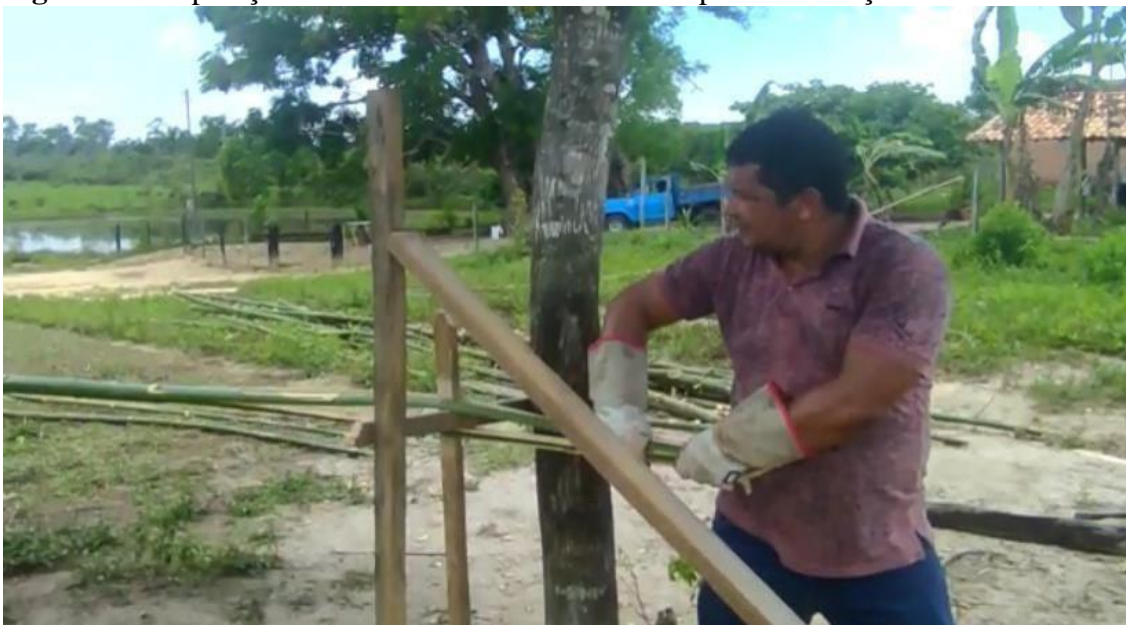
Figura 02 - Separação das varas de bambu em varetas para sua fixação nas estacas.
