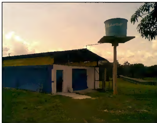
Figura 4 – Vista externa do galpão experimental.
