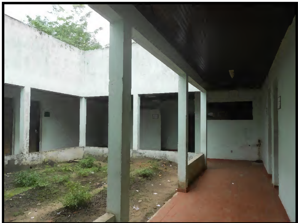
Figura 2: Estrutura predial onde se encontram as salas da Escola Virgílio Libonati.
