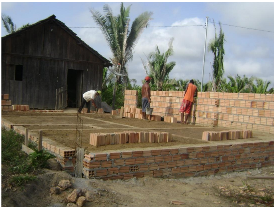
Figura 10 - Construção da primeira casa com recursos do Crédito para Aquisição de Materiais de Construção do INCRA, no PDS Virola Jatobá.
