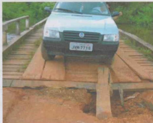
Figura 53– Condições de algumas pontes
