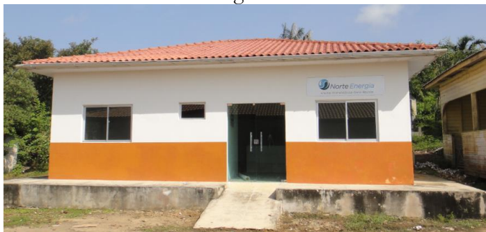
Figura 3 – Posto de saúde inoperante, construído pela Norte Energia S. A.
