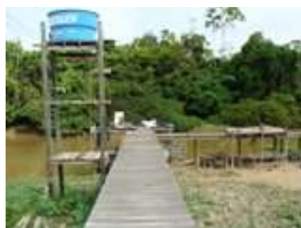
Figura 16. Caixa d'água com motobomba para captação de água do rio, em Cuieiras (QUINZEIRO NETO, 2010).
