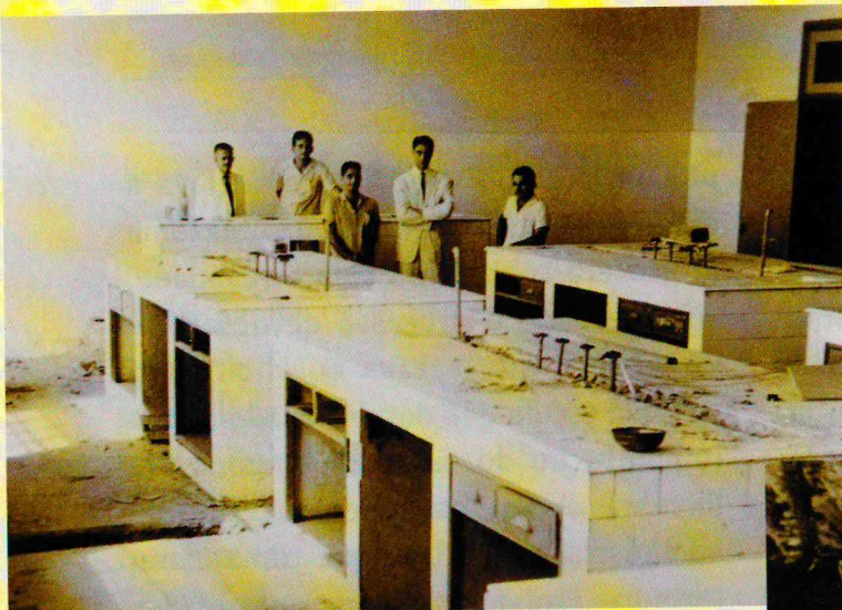
Construção do Laboratório de Química Escola de Agronomia da Amazônia
