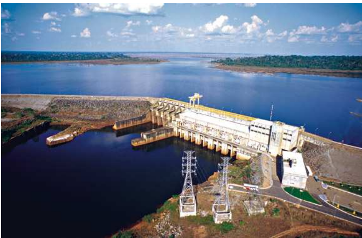
FIGURA 08: FOTO DA USINA HIDRELÉTRICA DE SAMUEL, RONDÔNIA
