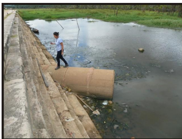
Fotografia 9 - Diques de contenção do bairro Caranazal.
