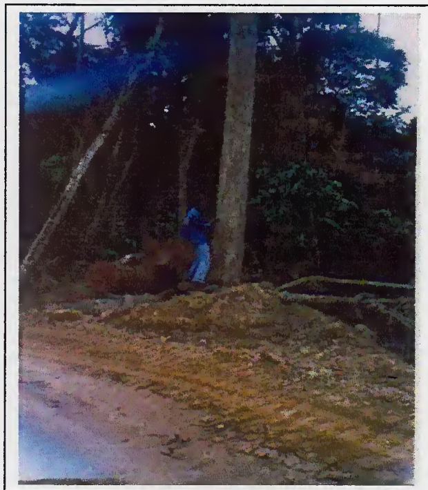
Figura 4b) Ao traçar os trilhos para transporte das toras, por falta de um planejamento inicial, várias árvores são destruídas, como observa-se na comuna do Luali. As restrições de árvores com DAP < 70 cm, preservou esta árvore de Pau rosa ( Swartzia fistuloides Harms) com DAP igual á 64 cm - 2001
