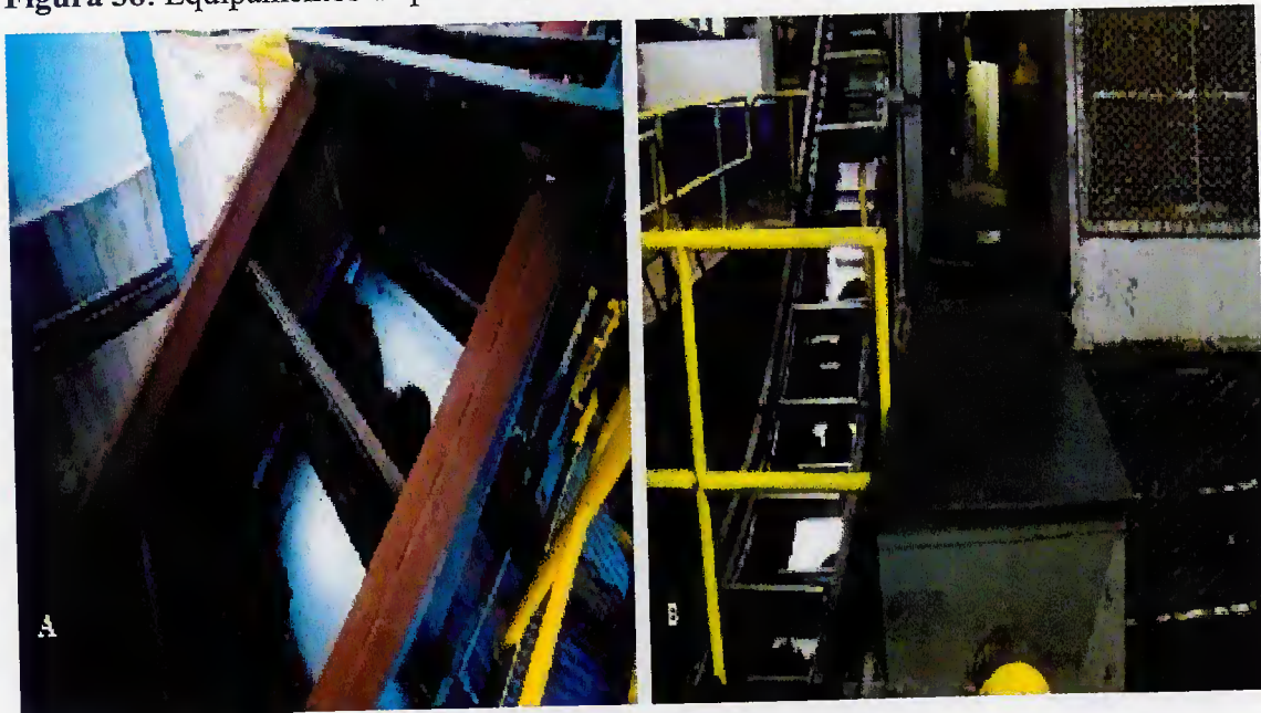
Figura 38: Equipamentos de processamento do óleo de dendê.
