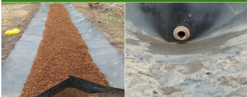
O passo-a-passo para fazer uma composteira usando geomembrana PEAD de 8mm para impermeabilização, coleta e recirculação de efluentes:
