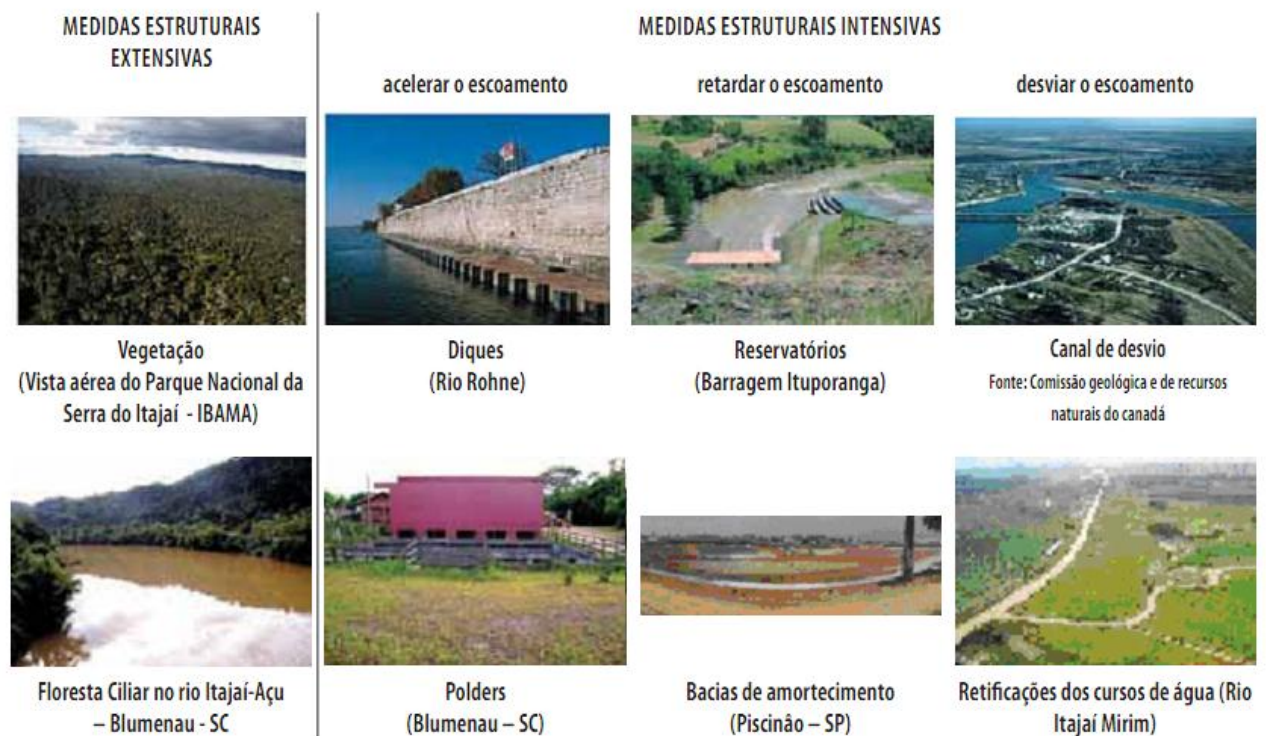
Figura 10 - Exemplos de obras estruturais.
