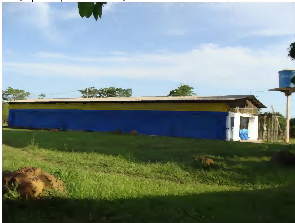
Figura 1 - Galpão Experimental da Universidade Federal Rural da Amazônia
