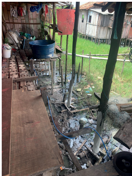
Figura 4 - Destinação inadequada do esgoto ao lado de residências.
